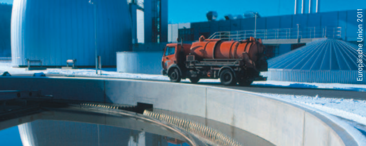
Abwasseraufbereitungsanlage in Gera, Thüringen. Kofinanziert durch EFRE
